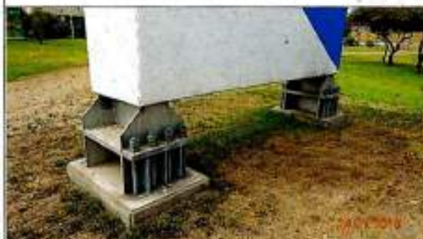
Fotografía N° 7: Tótem, cimientos y pedestal.
